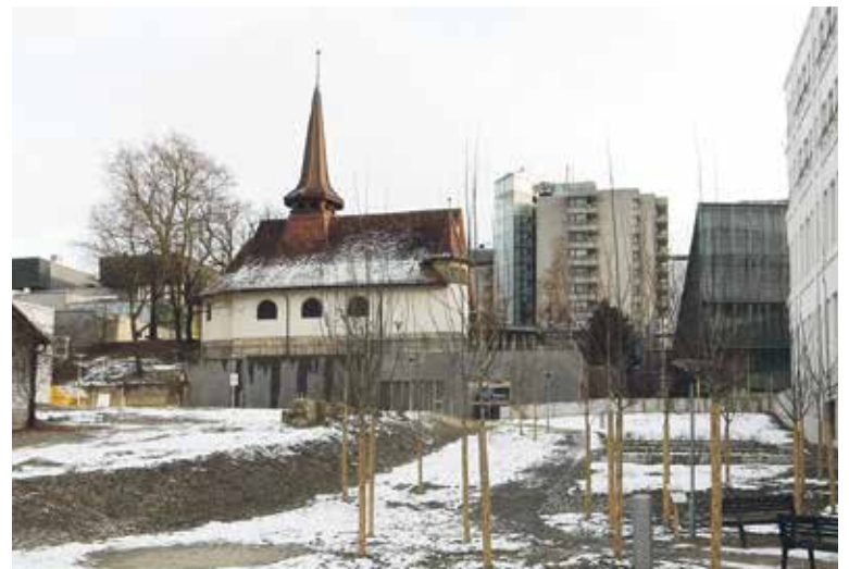
Umzingelt vom Bettenhochhaus, INO, Theodor-Kocher-Haus und Baustellen: Neben der Indermühle-Kapelle schaut rechts auch noch ein Stückchen der modernen Rigert-Kapelle hervor. Bildnachweis: Hadi (Wikipedia Commons)
