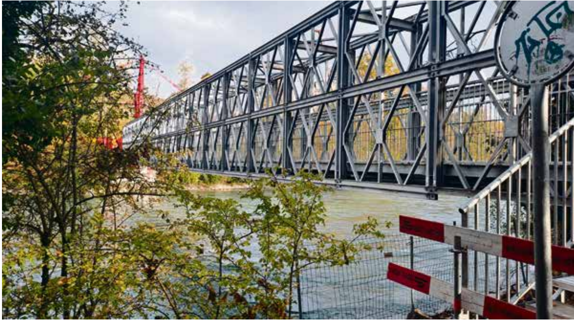
Der Ersatzsteg wurde Ende Oktober 2024 eingebaut (Foto: Patrick Krebs)
