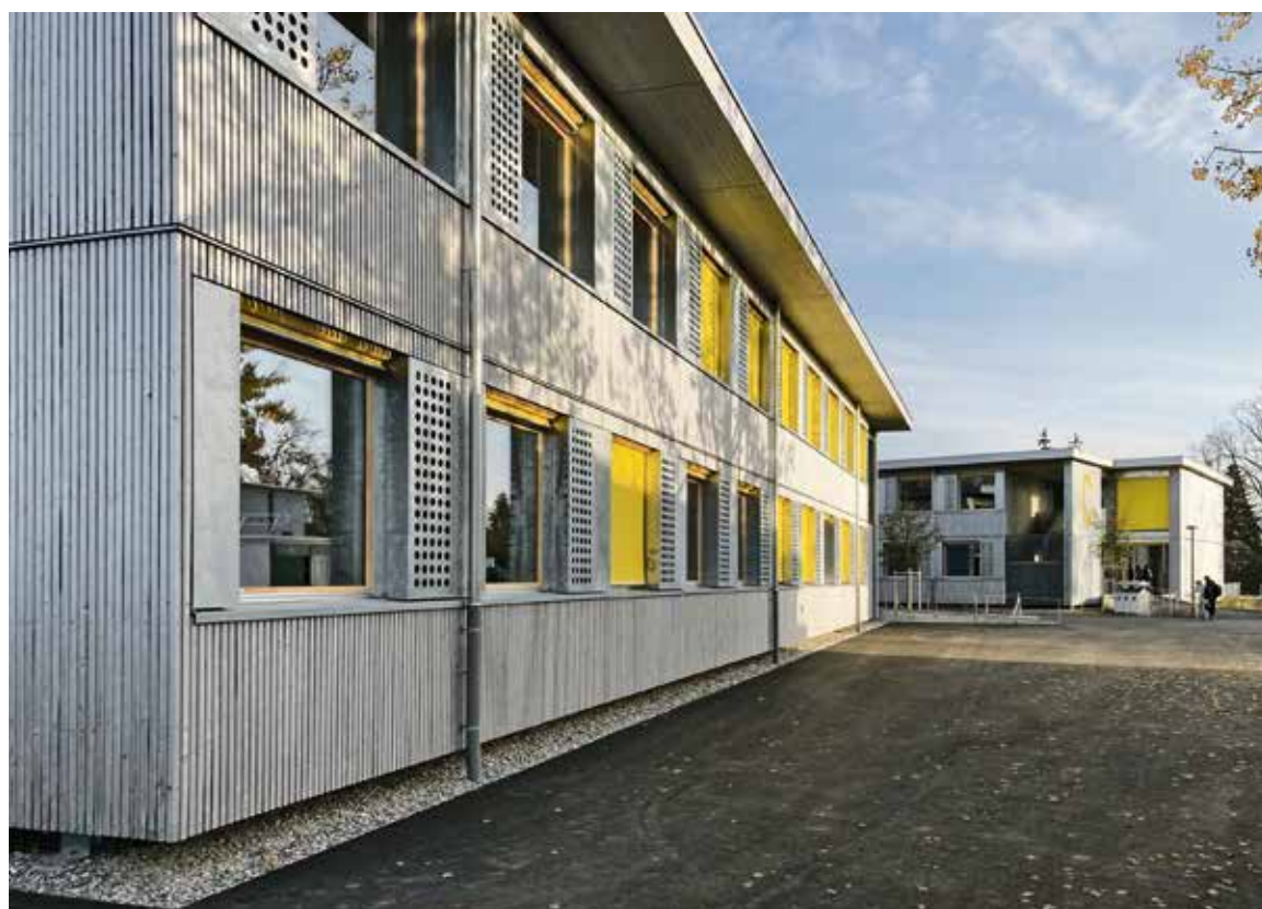
Die Schulräume werden in Modulbauweise erstellt. Auf dem Bild ist das Schulraumprovisorium vom selben Typ im Brünnpark zu sehen. (Bilder: Stadt Bern)
