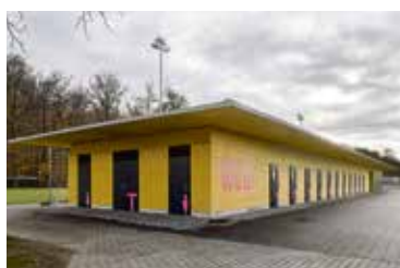
Die Garderobenanlage wird von der gleichen Bauart wie jene des Sportplatzes Bodenweid an der Freiburgstrasse sein.
