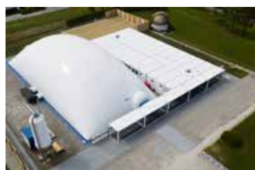
Für den Sportunterricht wird eine Traglufthalle aufgebaut.
