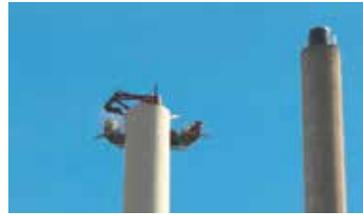
Der Rückbau der ehemaligen Kehrrechtverbrennungsanlage schreitet voran: Bis Ende November werden die prägnanten Betonkamine rückgebaut. Da der Beton wiederverwendet werden soll, werden die Kamine nach der Innenreinigung mit einem Spezialbagger von oben «runtergeknabbert» (siehe Bild). Anfang Dezember wird das von weit her sichtbare «Wahrzeichen» von Holligen Geschichte sein.
