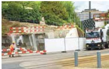
Als eine der Hauptherausforderungen im Projekt stellte sich das Schneiden der Stützmauer heraus: Um die Treppenstruktur auf die bestehende Mauer zu übertragen, musste diese auf einer Länge von rund 20 Metern heruntergewaschen und von Moos und Dreck befreit werden. Vom Geometer wurden dann die Vermessungspunkte gesetzt und vom Unternehmer gemäss Plänen die erforderlichen Schnitte angezeichnet. Aufgrund der gewölbten Form der Mauer ist das Errichten eines präzisen Stufenauflegers Millimeterarbeit.
